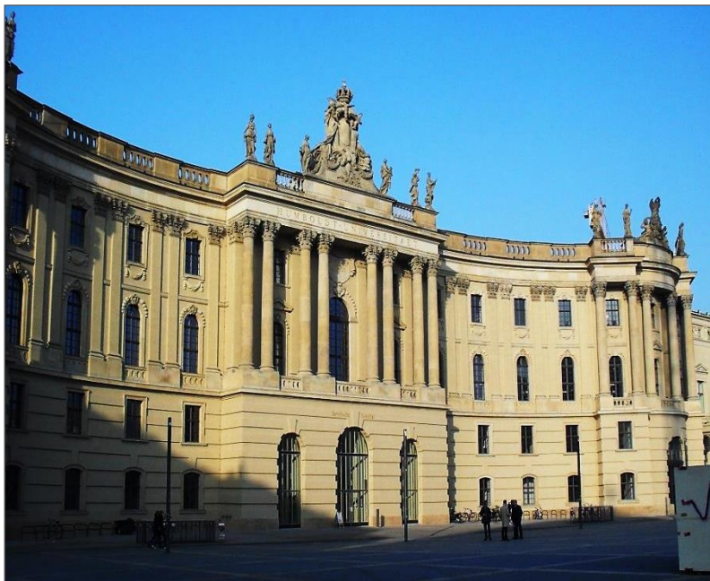
Rys. nr 4. Architektura budynku (nacisk na wizerunek fasady – fasada postaci, ze zbioru w posiadaniu autora)
